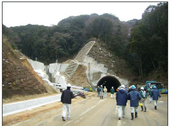
トンネル工事の全景
