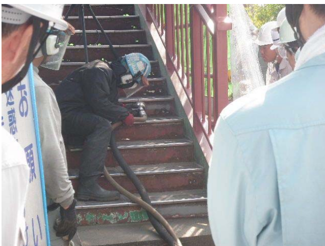
ブラスト施工状況
