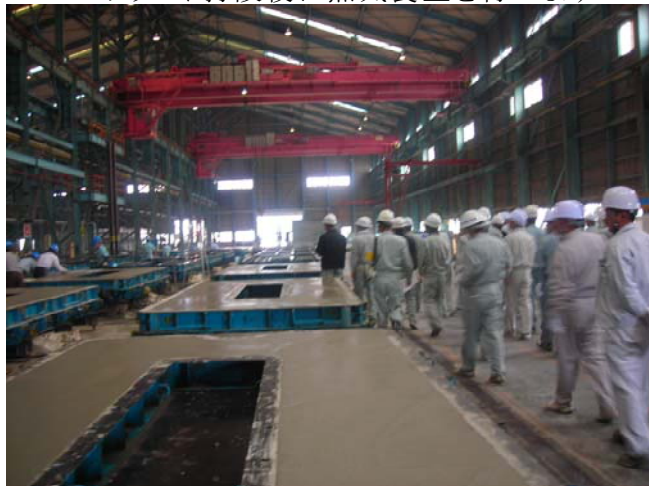
コンクリート打設後に蒸気養生を行います
