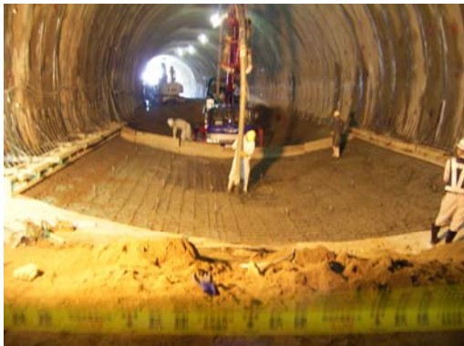
インバート配筋・打設
