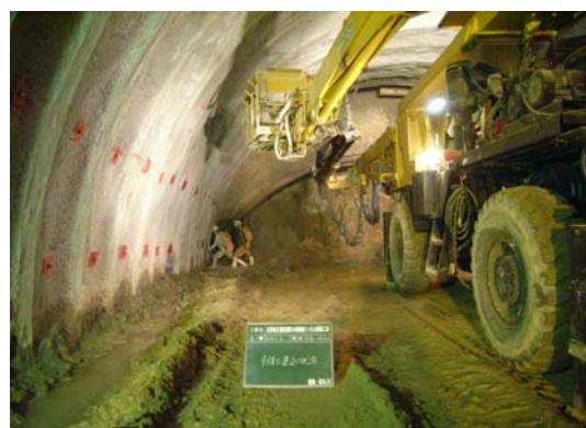
②鋼アーチ支保工建込
