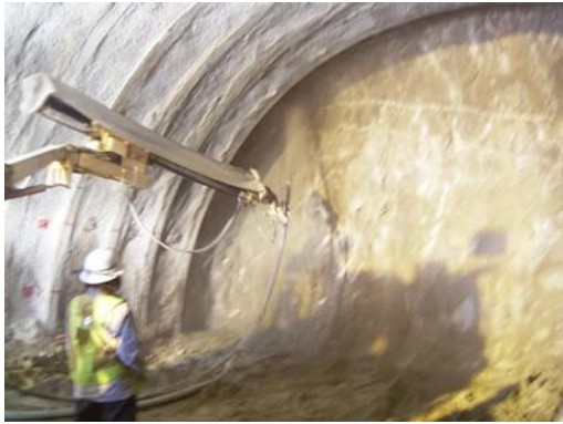
④コンクリート吹付け
