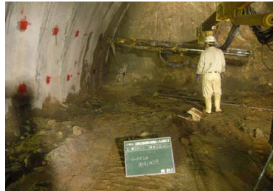
⑤ロックボルト削孔・打設
