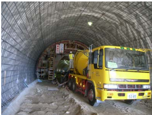
覆工コンクリート打設
