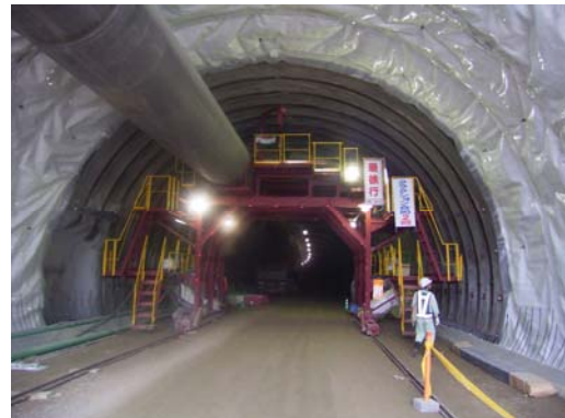
防水シートとスライドセントル
