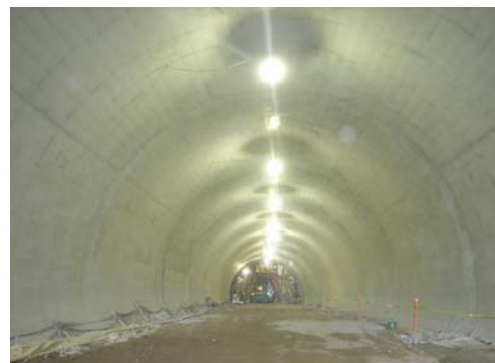
覆工コンクリート完了
