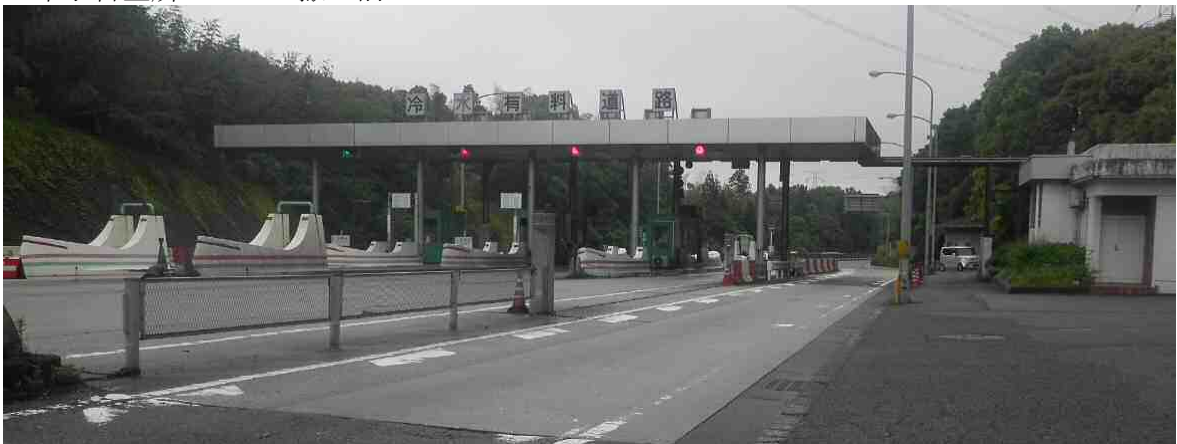
<冷水料金所 ブース撤去前>
