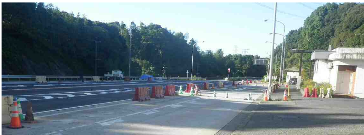
<冷水料金所 ブース撤去後>
