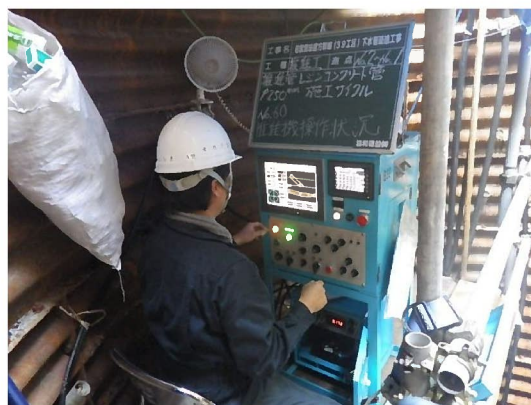
写真：推進機操作状況
