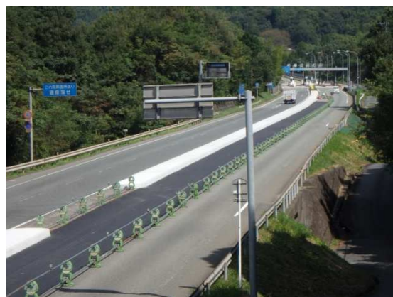
写真 4. 工事中のため植栽のない時期の様子
