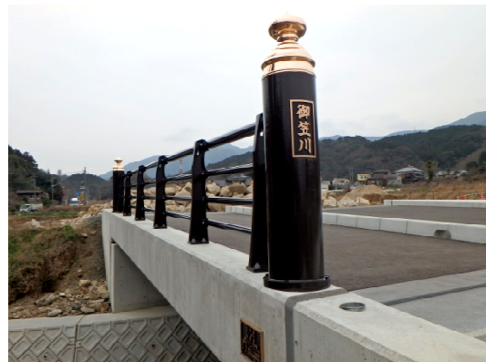
写真2. 同バイパス・新設橋梁
