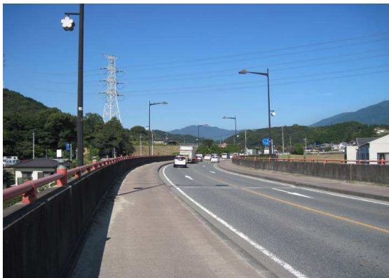
写真1. 県道筑紫野古賀線・太宰府大橋
