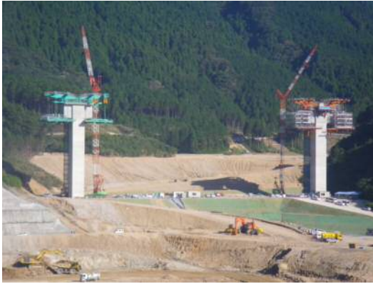
写真-3.4 倉谷大橋上部工施工状況
