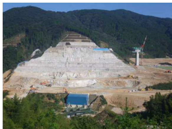
写真-3.3 原石山掘削状況
