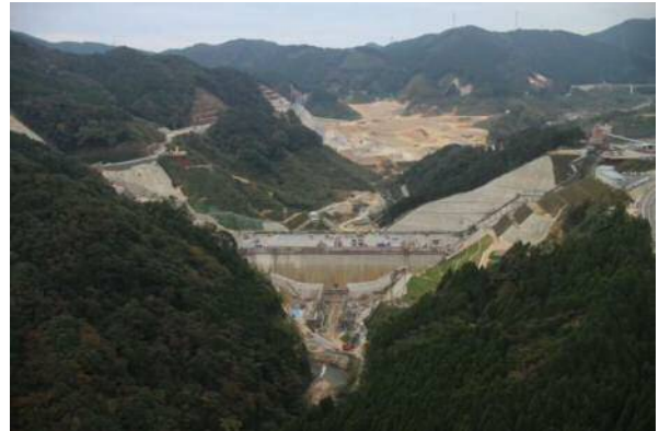
写真-3.1 下流側より堤体を望む
