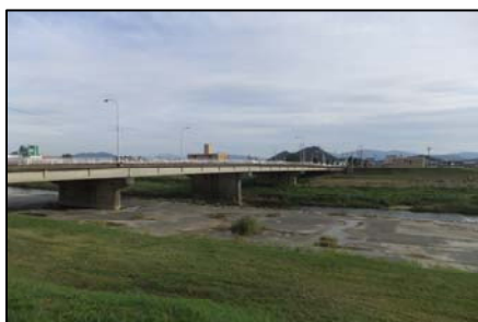
橋梁名：徳前大橋 材料区分：PC 橋 橋長：132.0m 径間数：4 径間 架設年：1971 年
