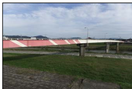
橋梁名：駅通り橋 材料区分：鋼橋 橋長：144.4m 径間数：4 径間 架設年：1974 年
