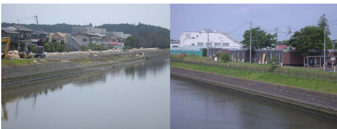
(写真 32・33) 復旧工事中の護岸とその対岸にある仮設住宅
