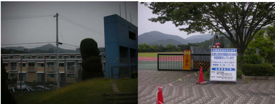
(写真⑥⑦) 野球場内の公営住宅と公営住宅建設のため地質調査中の陸上競技場
