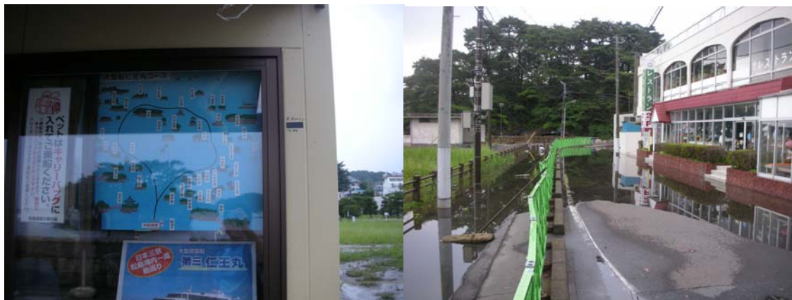
(写真⑯⑰) 津波による潮位を記した建物と地盤沈下して冠水したままの道路
