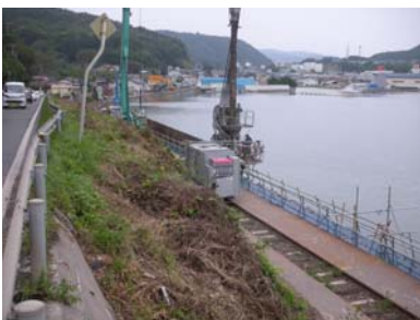
(写真⑧) 災害復旧中の鉄道
