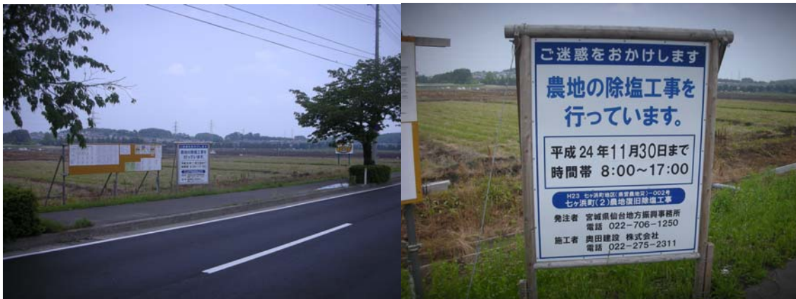
(写真 25・26) 農地の除塩工事の風景①
