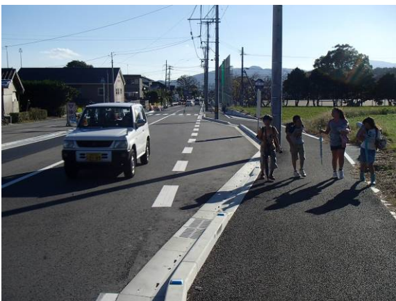
図-8 拡幅工事後の様子 2
