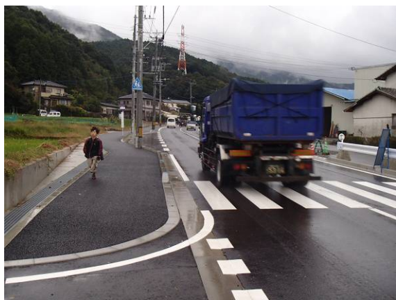
図-7 拡幅工事後の様子 1
