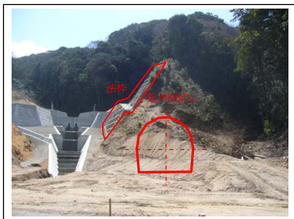
写真-2 起点側坑口付近着工前
