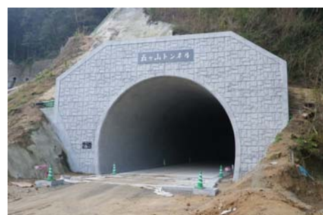
写真-1 起点側坑門
