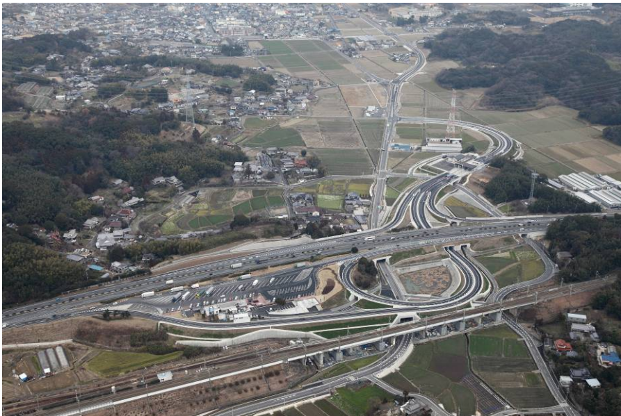
鞍手 IC 完成写真
