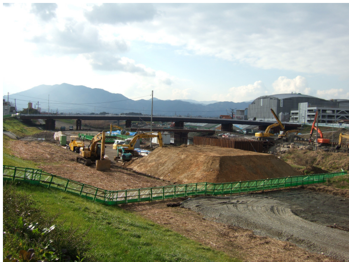
写真1～飯塚橋仮橋と下部工施工状況
