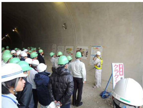
○三坂トンネル建設現場
