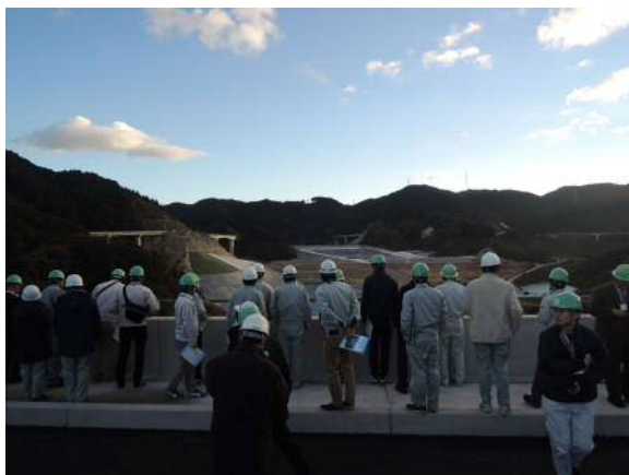
○五ヶ山ダム建設現場
